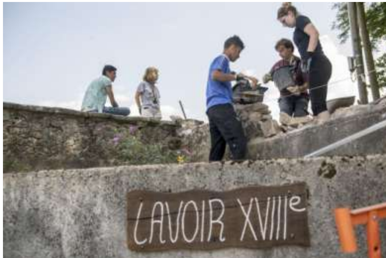
Travaux en cours (source La Montagne, 18/07/2018)
